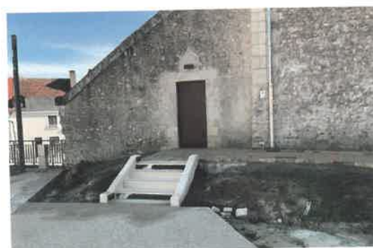
Accès PMR : travaux d'accès à l'église.
